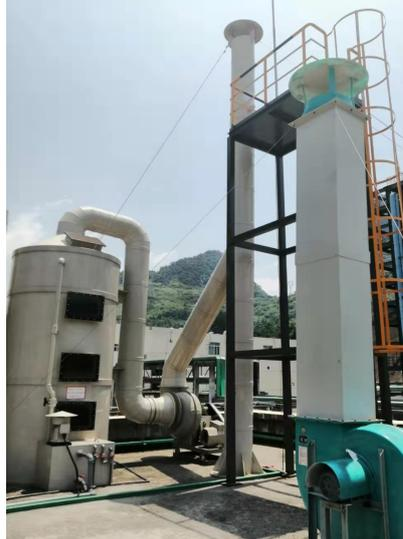
反应和压滤阶段氨气和干燥废气处理设施
