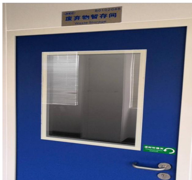
一般废物暂存间
