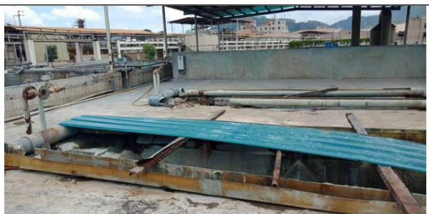
压滤机拆除后情况
