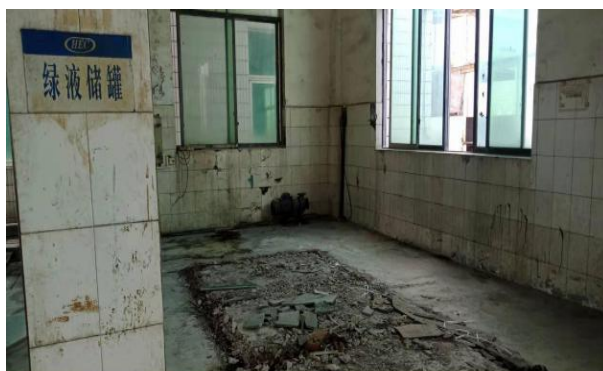
铬粉车间铬鞣剂储罐拆除后情况
