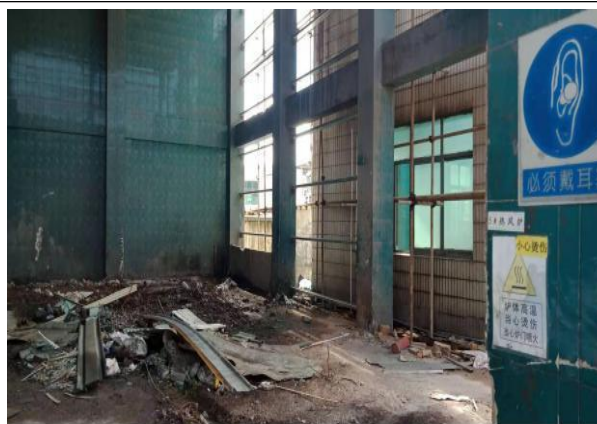
铬粉车间热风炉设施拆除后情况
