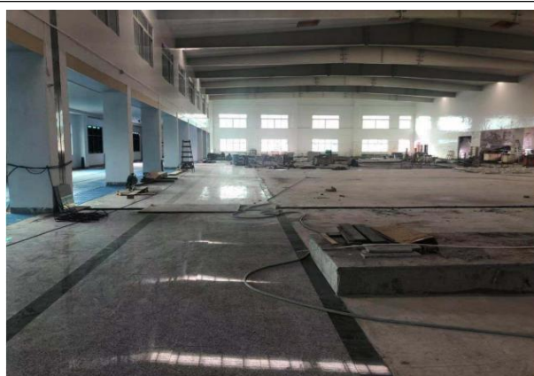
铬酸生产线及其辅助设施拆除后情况
