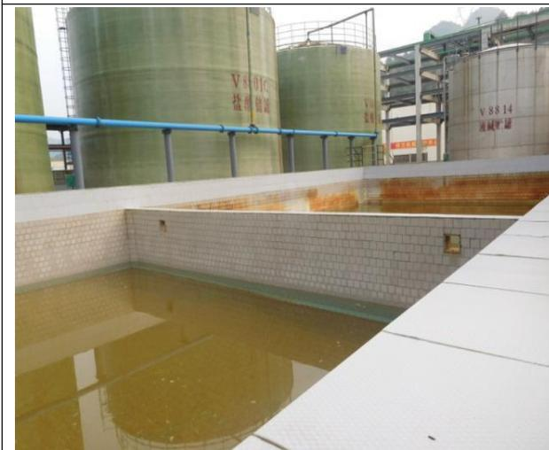
酸碱罐区围堰内的应急中和池
