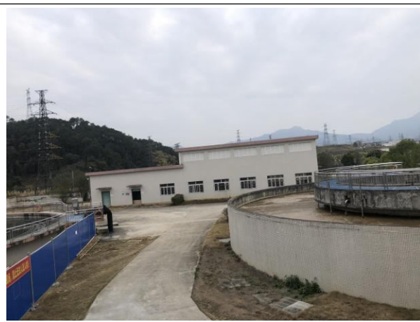
项目南面——污水厂一期工程
